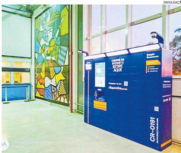
Os armários foram instalados em 12 estações da SuperVia
